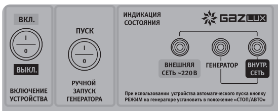
панель управления УАП-1
